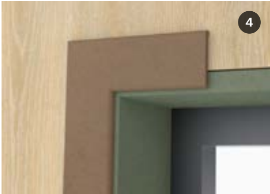
Raamafwerking met MDF en raamlijst.
