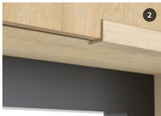
Raamafwerking met flexibel hoekprofiel
